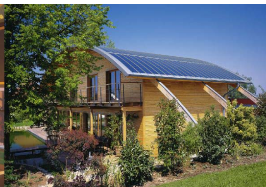
Solcellsintegrerat falsat plåttak, Rheinzink
